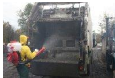
Фото. Дезінфекція контейнерів та сміттєвозів за допомогою аерозольних розпилювачів
